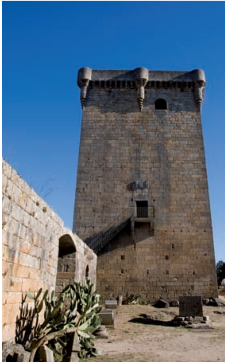
Torre da Homenaxe. Monterrei
