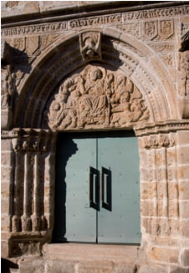
Monterrei. Hospital de peregrinos
